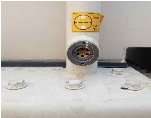
ที่วัดระดับน้ำมัน : Oil Level Indecater
