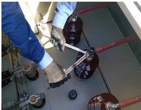
ชั้นฉนวนตัวต่อสายไฟฟ้าด้านแรงสูง
