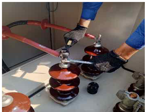
ขันอัดหัวต่อสายไฟฟ้าด้านแรงสูง
