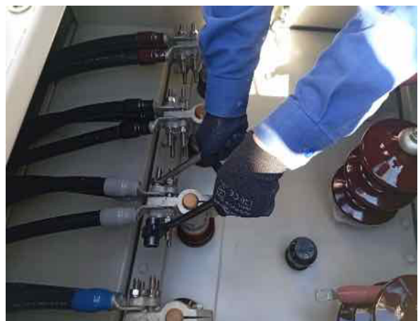
ขันอัดหัวต่อสายไฟฟ้าด้านแรงต่ำ
