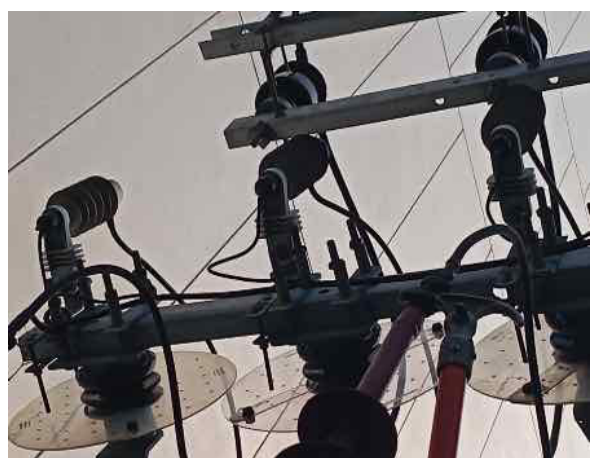
อุปกรณ์ป้องกันด้านแรงสูง : Lightning Arrester
