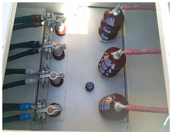
สภาพทั่วไปของบushing ด้านแรงสูง-ต่ำ
